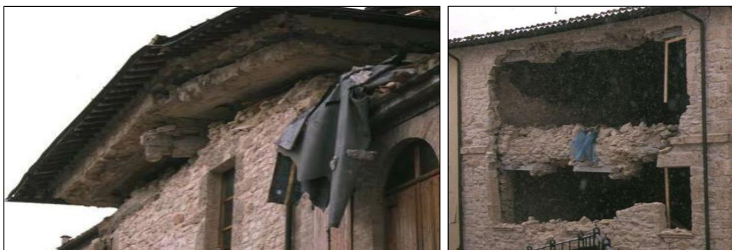
תרשים 5.10 אופני כשל אופייניים במבנה לא שלוד : נזק לקירות חוץ עקב החלפת תקרות קלות בתקרות כבדות מבטון.
