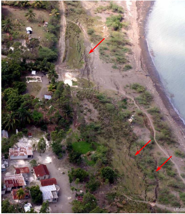
תרשים 8.6 בקעים עקב התפשטות קרקע אופקית, האיטי 2010. USGS Multimedia Gallery: Lateral Spread Caused by the Haiti Earthquake
