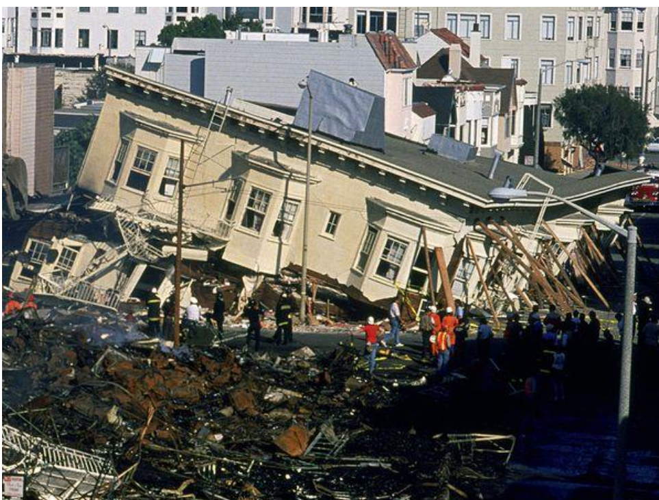
תרשים 8.3 נטיה ושבר במבנה עץ עקב תזוזות יחסיות אנכיות בקו שבר העובר תחת המבנה, סן פרנסיסקו, קליפורניה 1989.
