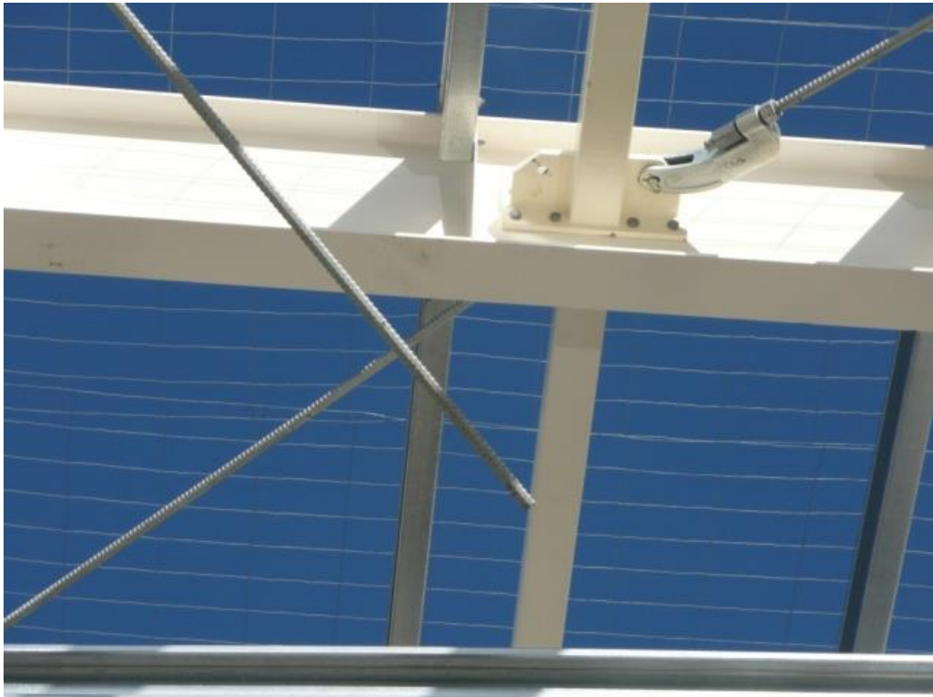
תרשים 7.5 כשל במחבר של מותחן במערכת הקשחה אופקית ברעידת האדמה Darfield, ניו-זילנד 2010.
