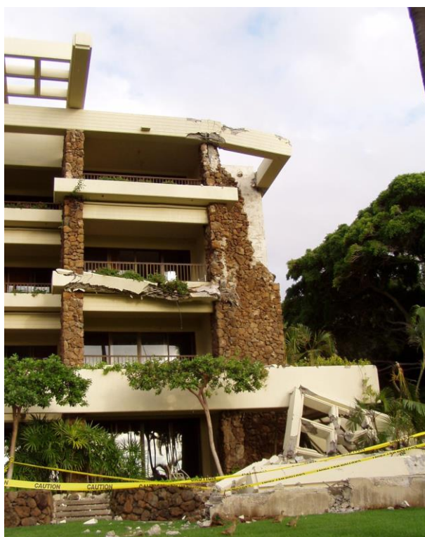
תרשים 9.1 התמוטטות חלקית של פרגולות וציפוי אבן ברעידה בהוואי 2006 מהווה גורם סיכון לנפילה ברעידה נוספת. גישה לאזור הסמוך לקיר נחסמה על ידי סרט סימון. EERI Special Earthquake Report – December 2006, “Preliminary Observations on the Hawai`i Earthquakes of October 15, 2006”
