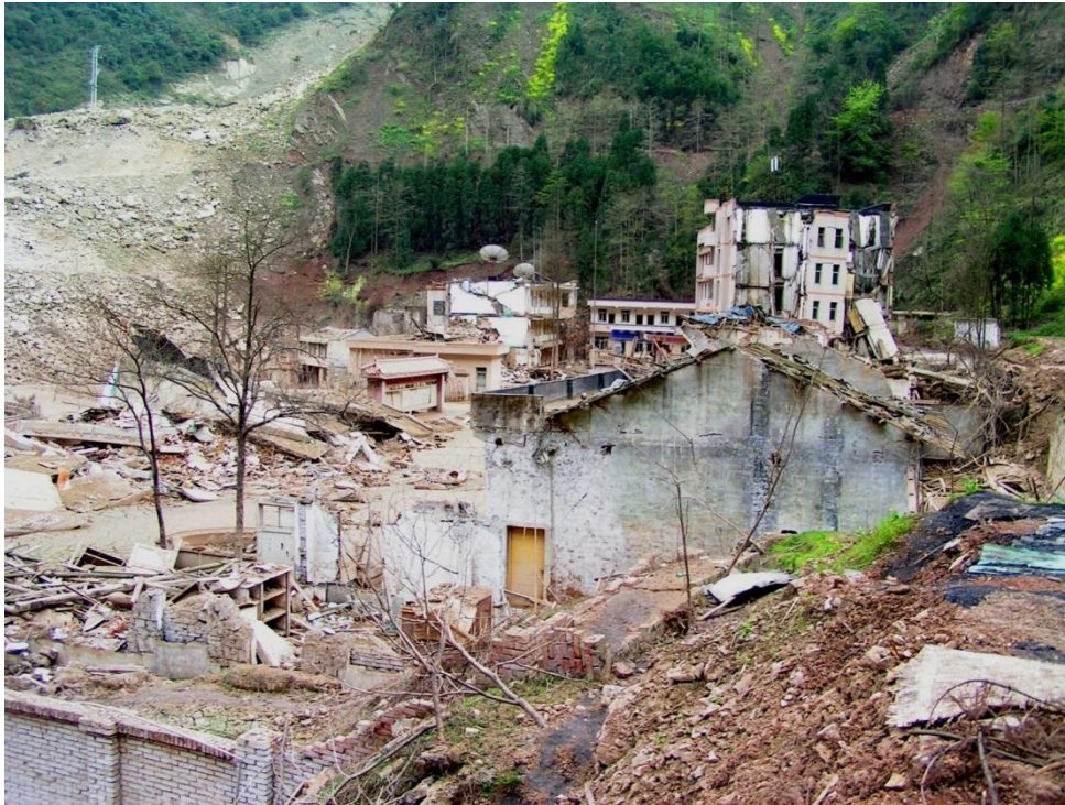
תרשים 8.4 הרס מבנה בית ספר כתוצאה מגלישת מדרון ברעידת אדמה סצואן, סין 2008. Dave's Landslide Blog, http://daveslandslideblog.blogspot.com/2009/03/images-of-landslides-and-other-damage.html
