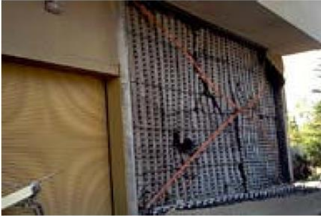
תרשים 7.4 נזילה וקריסה של אלכסוני הקשחה אופקית בקיר, רעידת האדמה San Fernando 1971 (NISEE, 2000).
