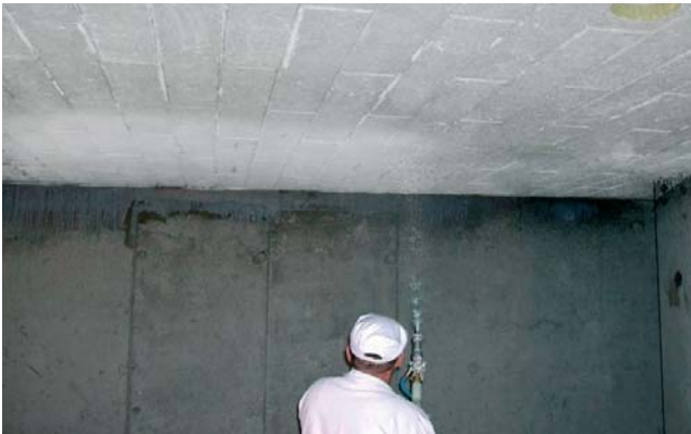
3. Påfør malingen ved å spraye den på ...
