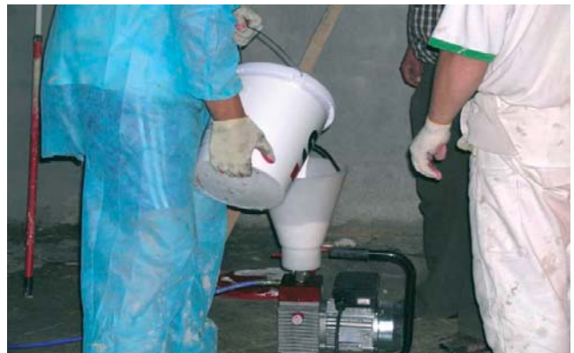
2. Fyll maling i malingsprøyten.
