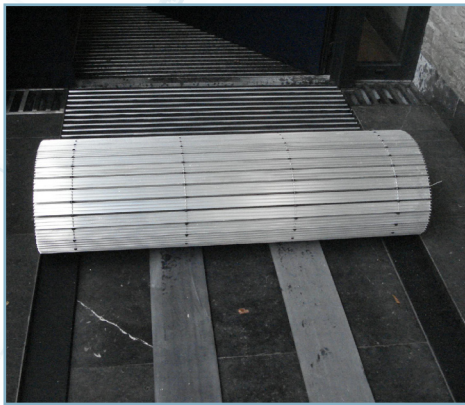
Aluminium profielen bekleed met antisliprubber
