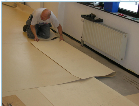
plaatsing op geegaliseerde chape
