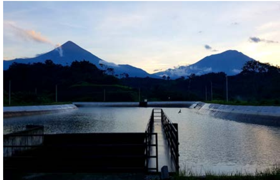
Central hidroeléctrica Las Fuentes II (Guatemala) donde construimos un embalse de desregulación que retoma al río el agua turbinada para no alterar su régimen natural.
