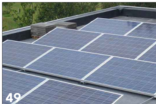
Zonnepanelen op plan dak met hogere dakrand/dakopstand
