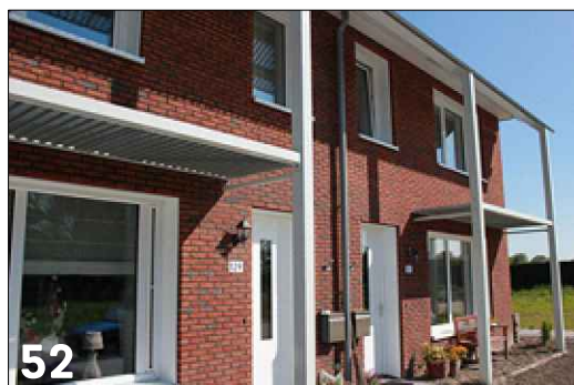
52 Toepassing van lamellen ten behoeve van schaduwwerking
