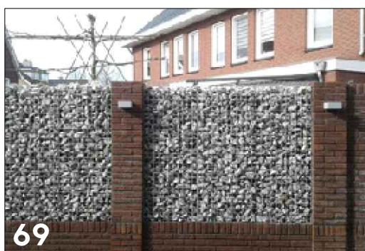
69 Hoogwaardige erfafscheiding waarbij metselwerk gecombineerd wordt met steenkorf
