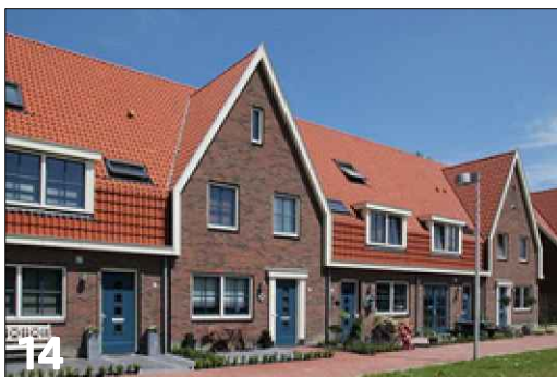
14 Vierkante gevelgeleding met toepassing van verschillende gevelcomposities
