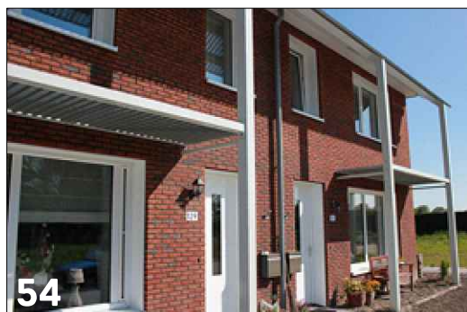
54 Toepassing van lamellen ten behoeve van schaduwwerking
