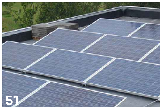
51 Zonnepanelen op plan dak met hogere dakrand/dakopstand
