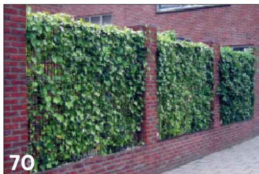
70 Hoogwaardige erfafscheiding waarbij metselwerk en groen gecombineerd is
