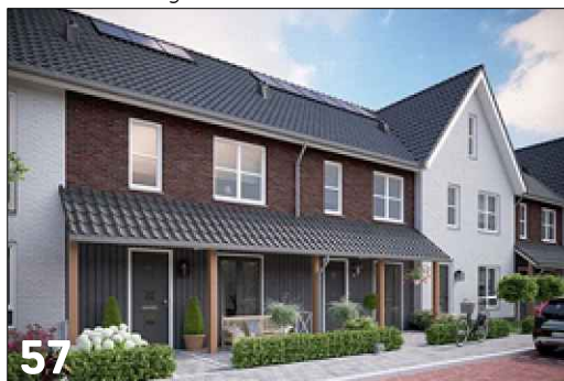
57 Dak overstek creëert schaduwwerking
