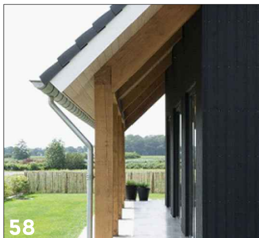
58 Dak overstek creëert schaduwwerking
