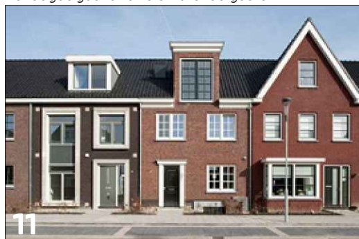
11 Vierkante gevelgeleding met toepassing van verschillende gevelcomposities
