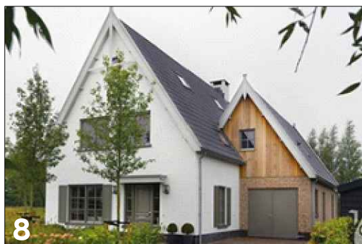
8 Vierkante gevelgeleding met toepassing van verschillend gevelmateriaal (stuc, hout en metselwerk)
