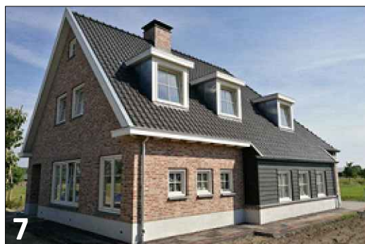
7 Vierkante gevelgeleding met toepassing van divers gevelmateriaal (stuc, hout en metselwerk)
