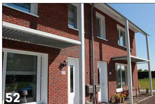
52 Toepassing van lamellen ten behoeve van schaduwwerking
