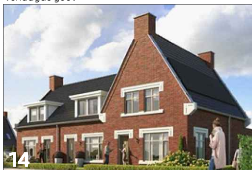
14 Accentuering van een vierkante gevelgeleding
