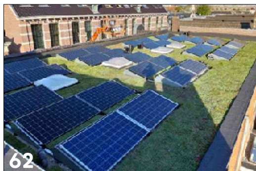
Extensief groen dak in combinatie met zonnepanelen
