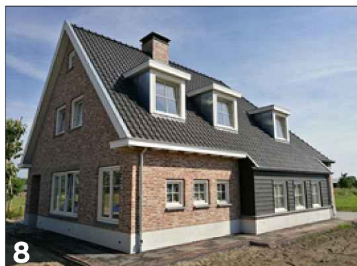
8 Vierkante gevelgeleding met toepassing van divers gevelmateriaal (stuc, hout en metselwerk)
