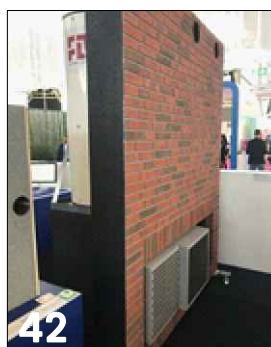
Buitenunit inpandig in gevel verwerkt
