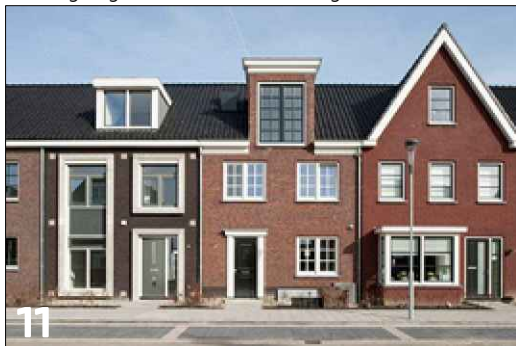
11 Vierkante gevelgeleding met toepassing van verschillende gevelcomposities
