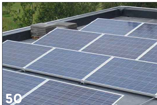
Zonnepanelen op plan dak met hogere dakrand/dakopstand
