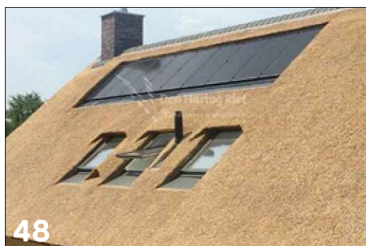
Zonnepanelen geïntegreerd in rieten dak
