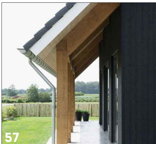
57 Dak overstek creëert schaduwwerking
