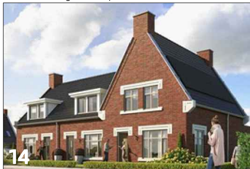
14 Accentuering van een vierkante gevelgeleding
