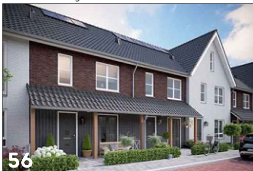
56 Dak overstek creëert schaduwwerking
