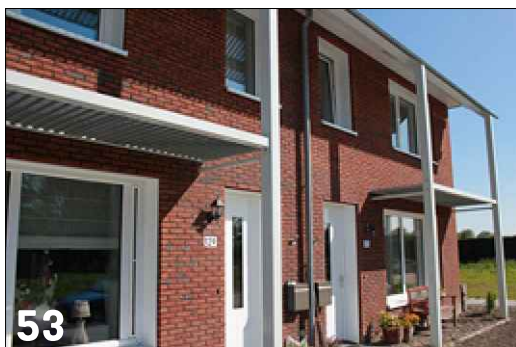
53 Toepassing van lamellen ten behoeve van schaduwwerking
