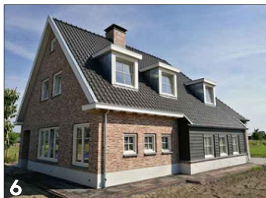
6 Vierkante gevelgeleding met toepassing van divers gevelmateriaal (stuc, hout en metselwerk)
