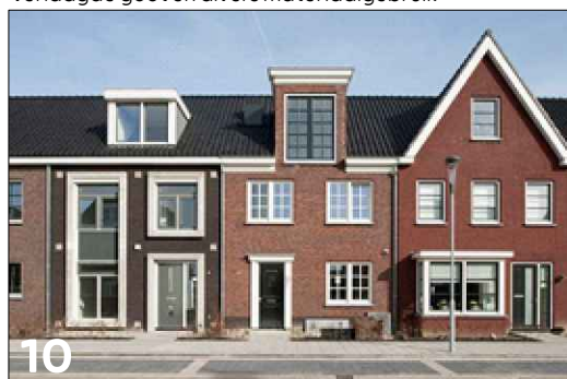
10 Vierkante gevelgeleding met toepassing van verschillende gevelcomposities
