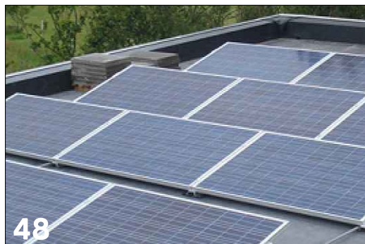
Zonnepanelen op plan dak met hogere dakrand/dakopstand
