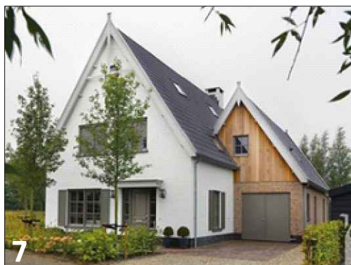
7 Vierkante gevelgeleding met toepassing van verschillend gevelmateriaal (stuc, hout en metselwerk)
