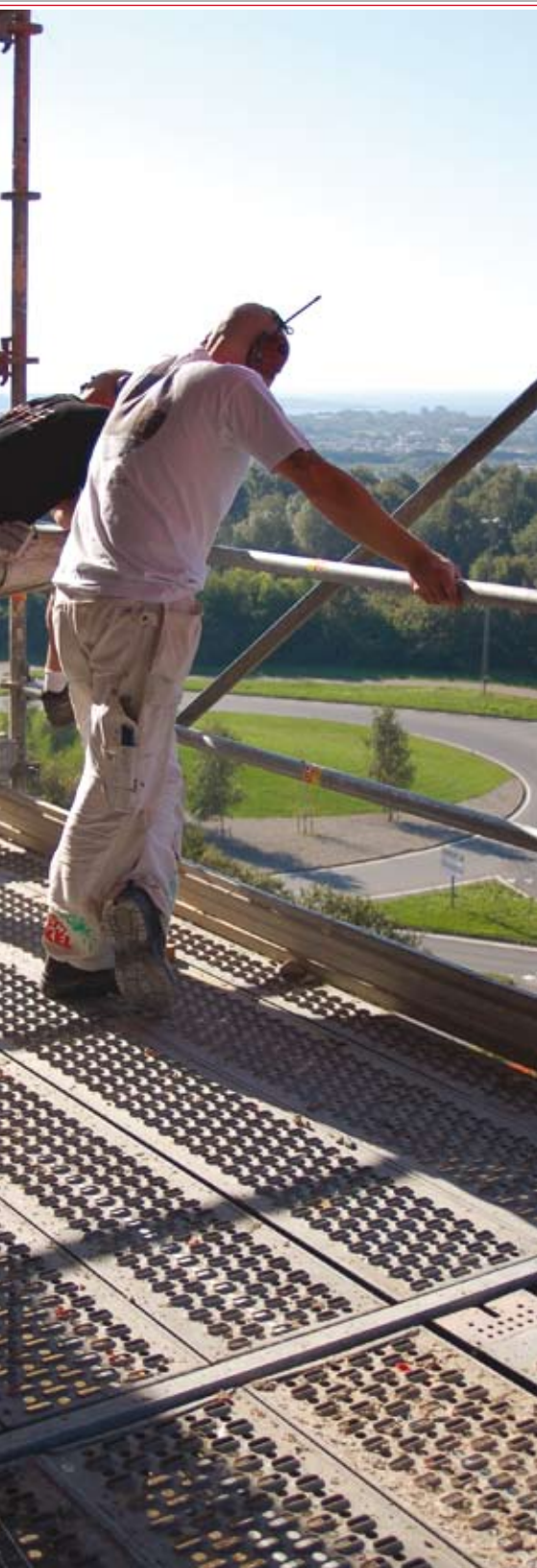
Spektakulär vy från arbetsplatsen. Utsikt söderut från femtonde våningen på Söderhöjd i Varberg.
