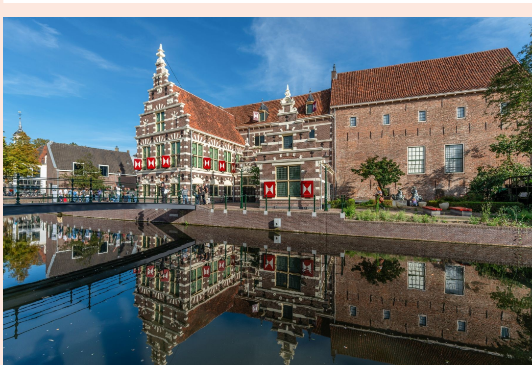
Museum Amersfoort is gebouwd op de restanten van de oude stadsmuur. Eerst het woonhuis van familie van Schayk, later een tabakspakhuis en sinds 1889 een museum. Foto: Erfgoedfoto
